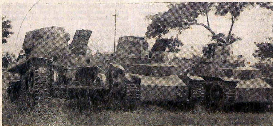
Jappentanks voor de sloper.
